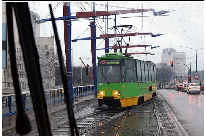
Rozjazd nakładkowy od strony mostu Dworcowego. Helmut oczekuje na „pionową kreskę”, podczas gdy przez zwrotnice przetacza się skład stopiątek (320+321) linii 15/5.
