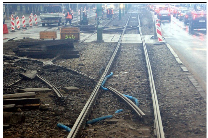
Demontaż rozjazdów prowadzących w kierunku ul. Towarowej. Dzięki ich likwidacji skrócono czas przejazdu przez odcinek jednotorowy – tramwaje nie muszą już tu zwalniać do 10 km/h.
