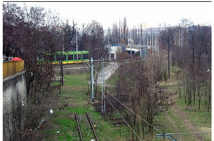
Przedłużenie PST ma być gotowe do Euro 2012. Na zdjęciu widoczne ślepe zakończenie torów postojowych dla EZT i słupy - pozostałość po niezrealizowanej pętli Most Teatralny.
