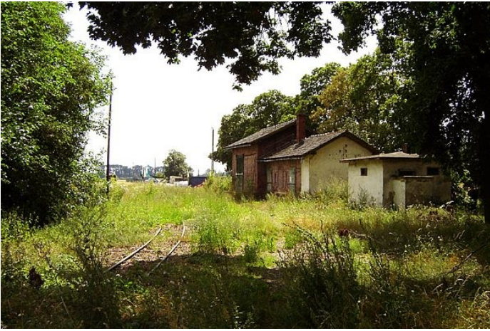
Śmigielska Kolej Dojazdowa. Widok na zdewastowany budynek stacyjny i peron w Wielichowie.
