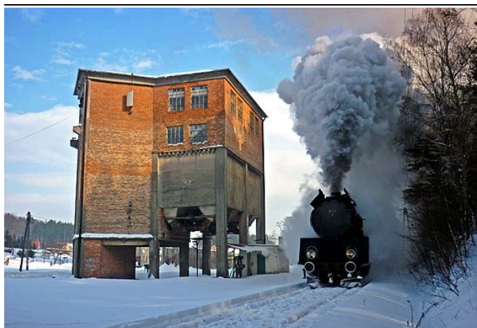
Sieniawa Lubuska, bunkier ładunkowy na 28. kilometrze linii Toporów – Międzyrzecz.
