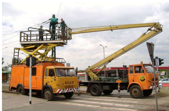
Demontaż starej trakcji. W akcji wozy #2217 i #2190. Fot.: Marcin Jurczak, 01.07.2005
